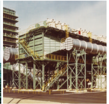
• 卧式湿式ESP结构图
