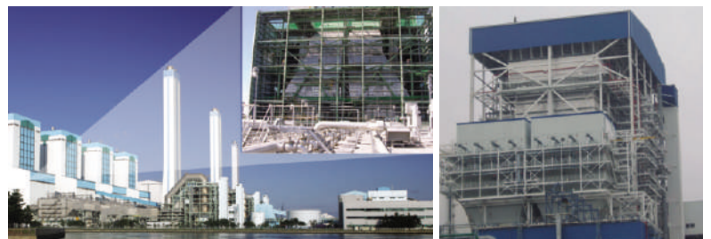
• 唐津火电厂脱硝设备
